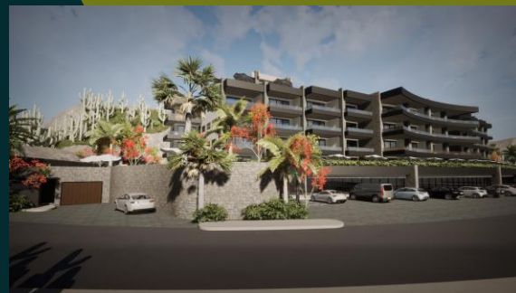
CONDOMINIOS DE CORTÉS CABO SAN LUCAS, B.C.S. 2021
